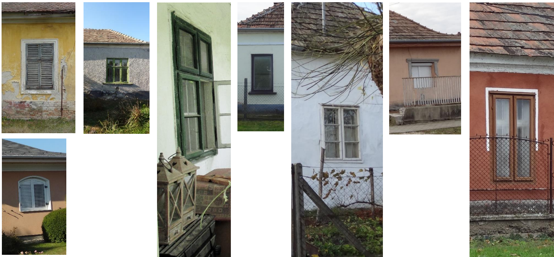
51. kép: Hagyományos gerébtokos és újabb szerkezetű ablakok. A régi épületek szabályos vakolatkeretei a jó példák az
