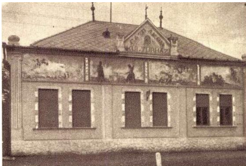
36. kép: Volt gazdakori épület régen és ma. Itt nem javasolható a teljes rekonstrukció a túl széles homlokzati fríz miatt.
